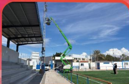
NUEVAS GRADAS, MARQUESINA E ILUMINACIÓN EN EL CAMPO DE FÚTBOL
