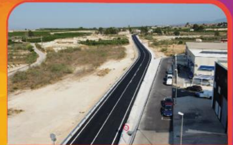
OBRAS DE ASFALTADO DE LA CARRETERA DE ALGUAZAS A CAMPOS DEL RÍO
