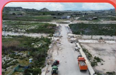
LIMPIEZA DE ESCOMBROS Y ENSERES EN EL POLIGONO INDUSTRIAL LAS PULLAS
