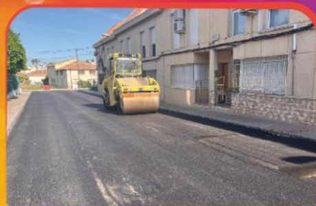
ASFALTADO DE CALLE MURILLO
