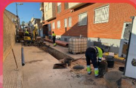
RENOVACIÓN DE REDES DE SANEAMIENTO EN CALLE DOCTOR MARAÑÓN
