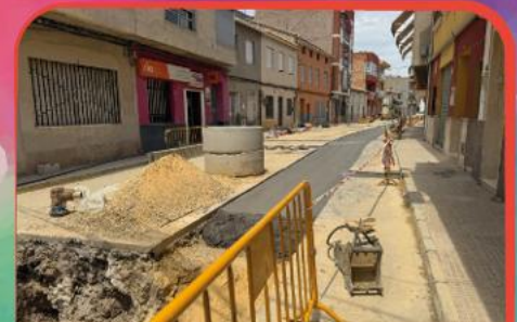
RENOVACIÓN DE REDES DE SANEAMIENTO EN CALLE ESCUELAS
